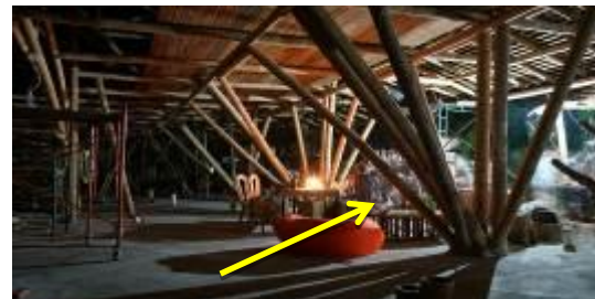
Gambar 6 :Tiang-tiang bambu pada pondasi umpak batu kali
