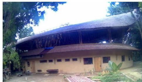
Gambar 9 Dinding pada bangunan
