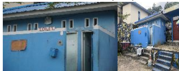
Gambar 6. Area Toilet dan pos Security Sumber: Penulis (2023)
